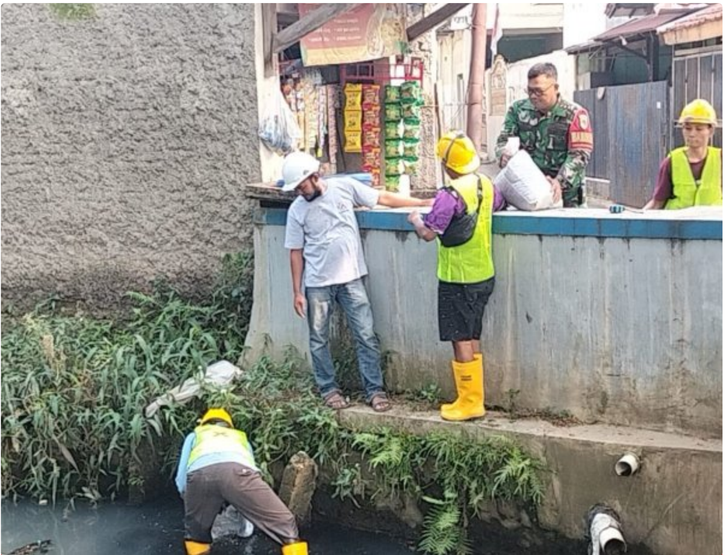
Babinsa Pekiringan Terlibat Langsung dalam Pekerjaan Awal Pembangunan Jembatan Armco
