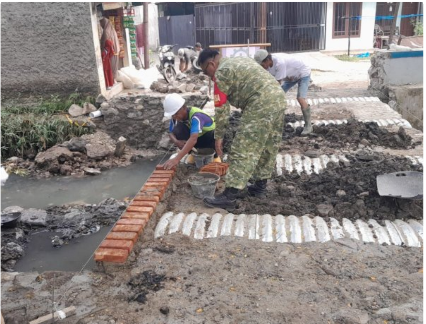
Babinsa Pekiringan Bersama Warga Laksanakan Kerja Bakti Pembuatan Jembatan Armco
