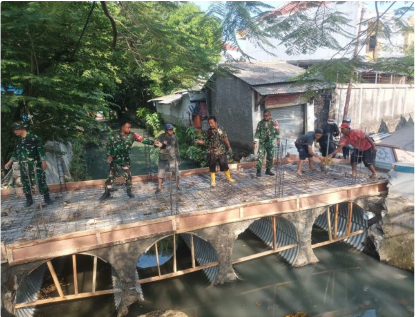
Babinsa Pekiringan Bersama Warga Laksanakan Gotong Royong Pengecoran Jembatan Armco
