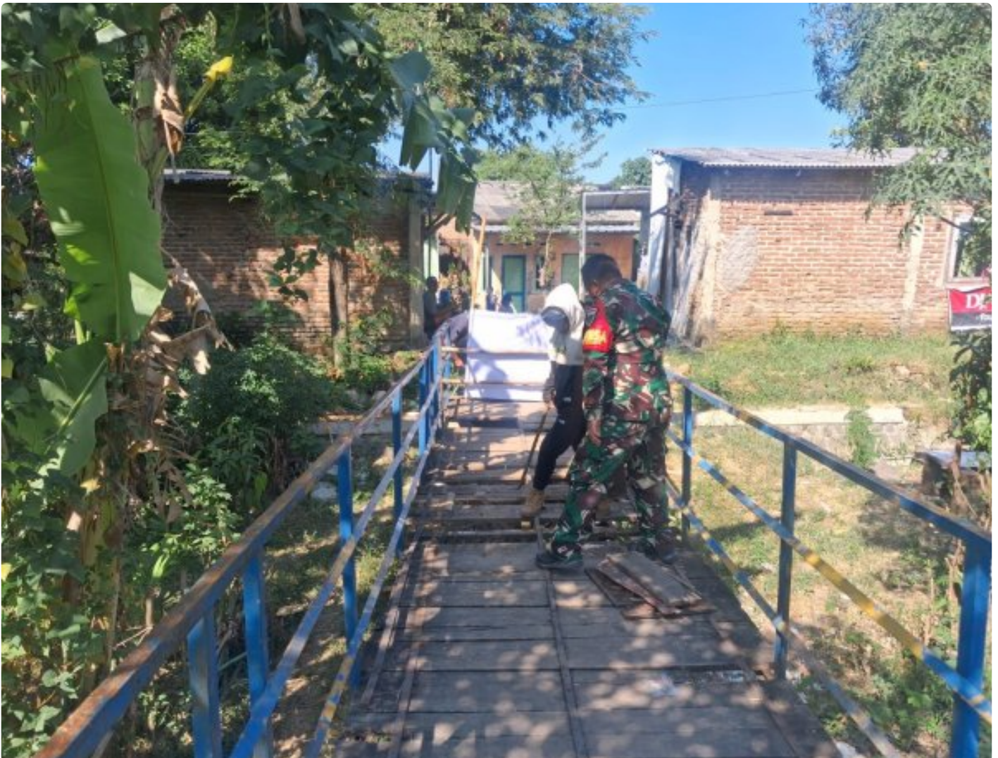
Perbaiki jembatan Gantung Kel. Kecapi Kota Cirebon
